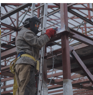
Строительство, монтаж металлоконструкции
